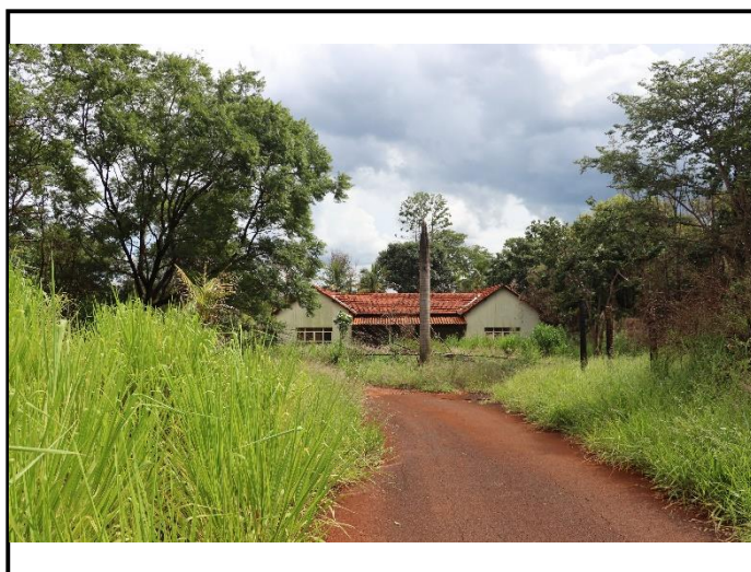
Foto 4 – Benfeitorias construtivas – casa sede
