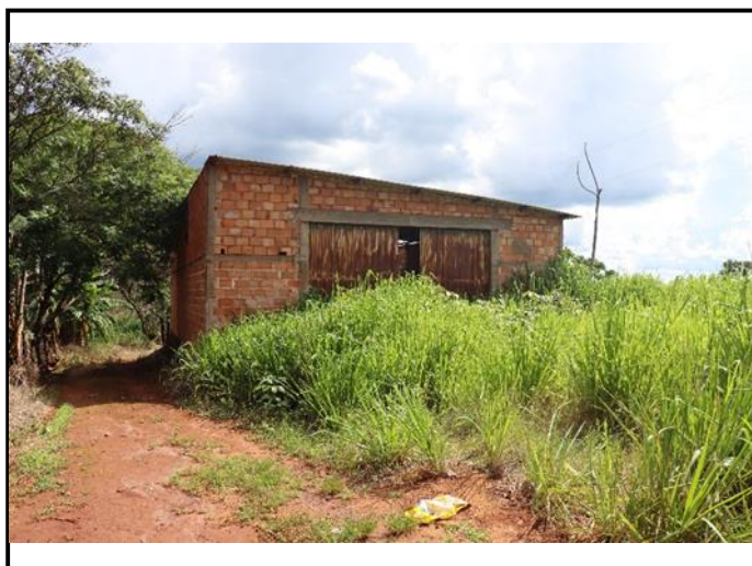
Foto 11 – Galpão de alvenaria e telhado de amianto.
